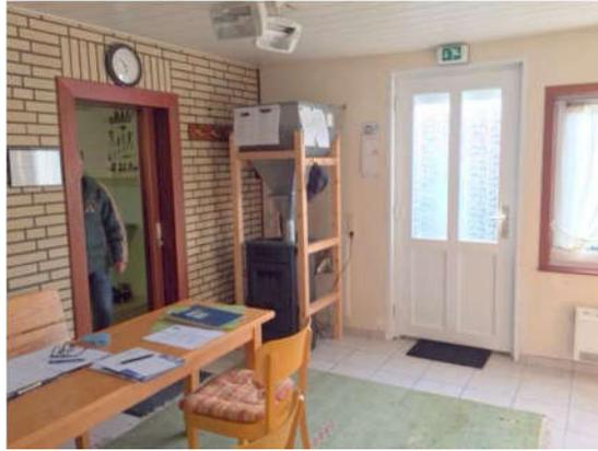
*Beispiel einer halbautomatisch beschickten Pelletheizung*
